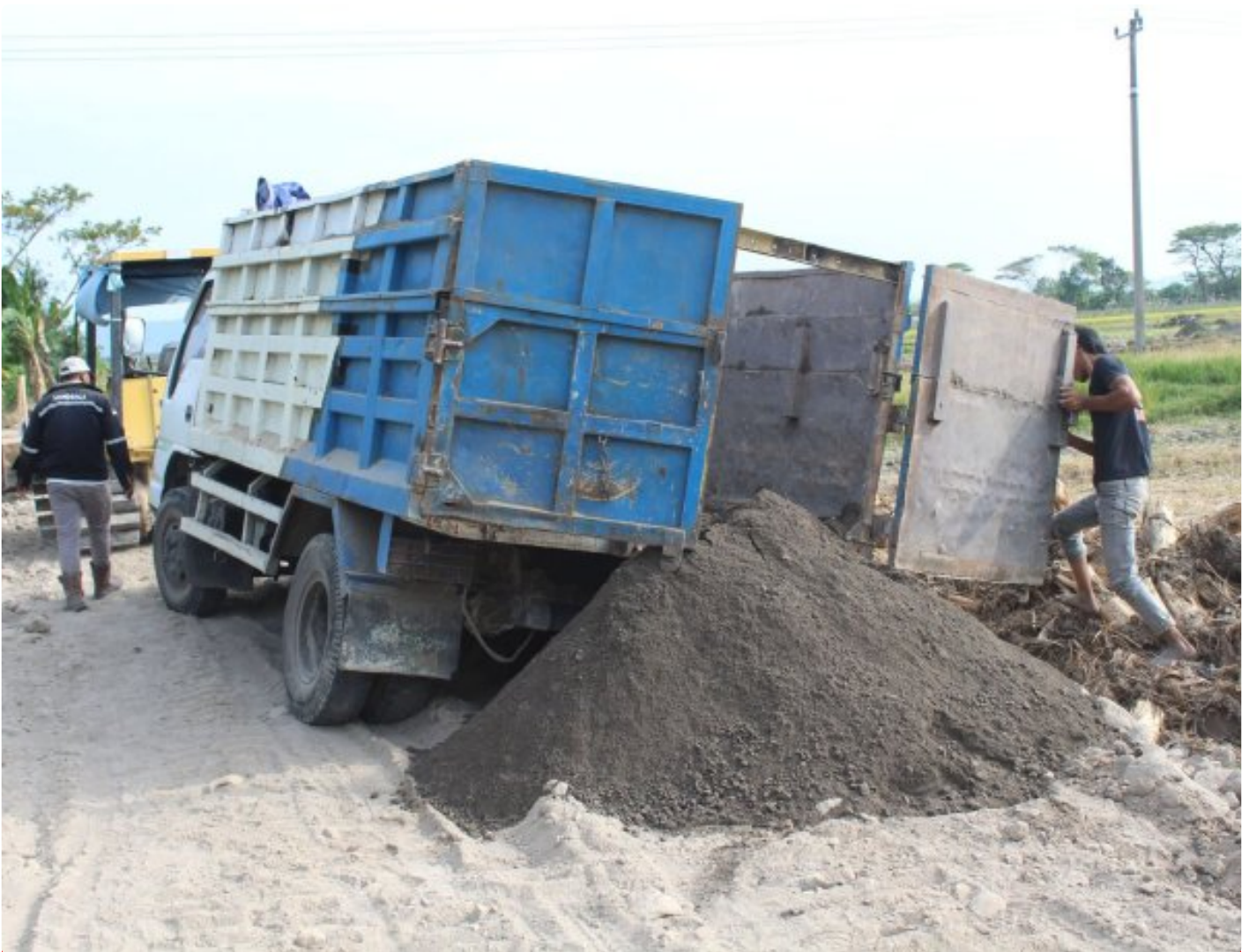
Droping Material Ke Lokasi TMMD Reg 121 Kodim Klaten
